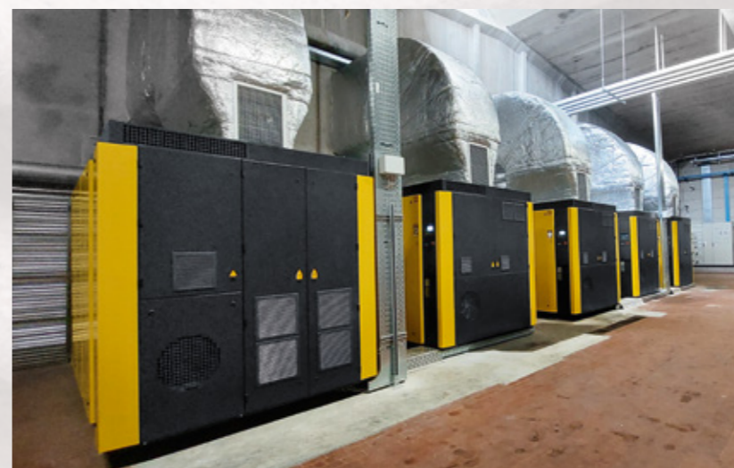
Fotografía de la izquierda: Cervotessile es conocida por sus productos de alta calidad, que cuentan una historia impregnada de tradición. Fotografía de la derecha: la nueva estación de aire comprimido está formada por cinco compresores KAESER.
